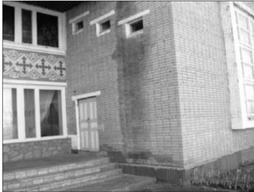
Водные дорожки видны уже на наружной стене ДК
