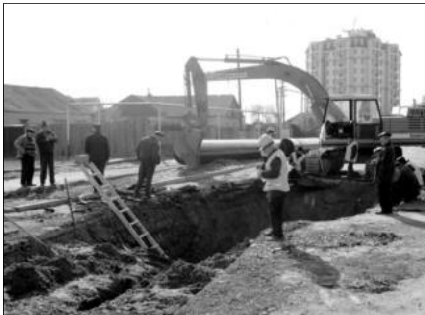
Новая канализационная «нитка» из полиэтиленовых труб не потребует замены 50 лет, обещают строители
