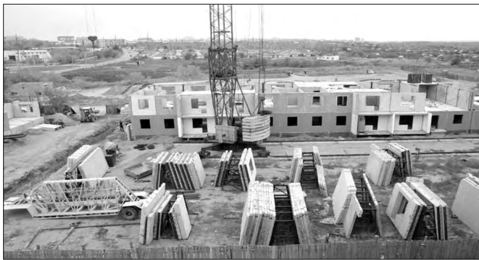
Между этими снимками интервал почти в два месяца. К октябрю строительство продвинулось только на один этаж вверх
