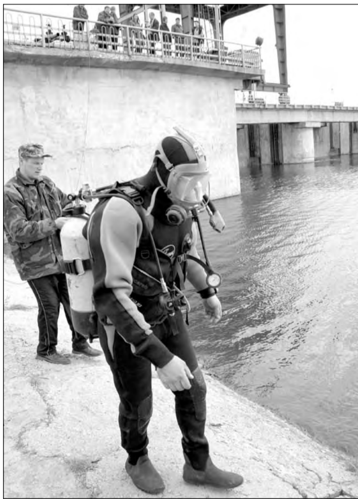
Водолазы приступили к обследованию подводной части гидроузла
