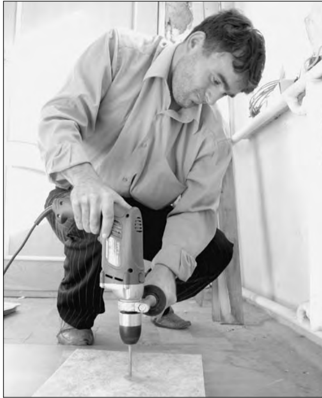
Просверлить кафель можно только при помощи победитовой насадки
